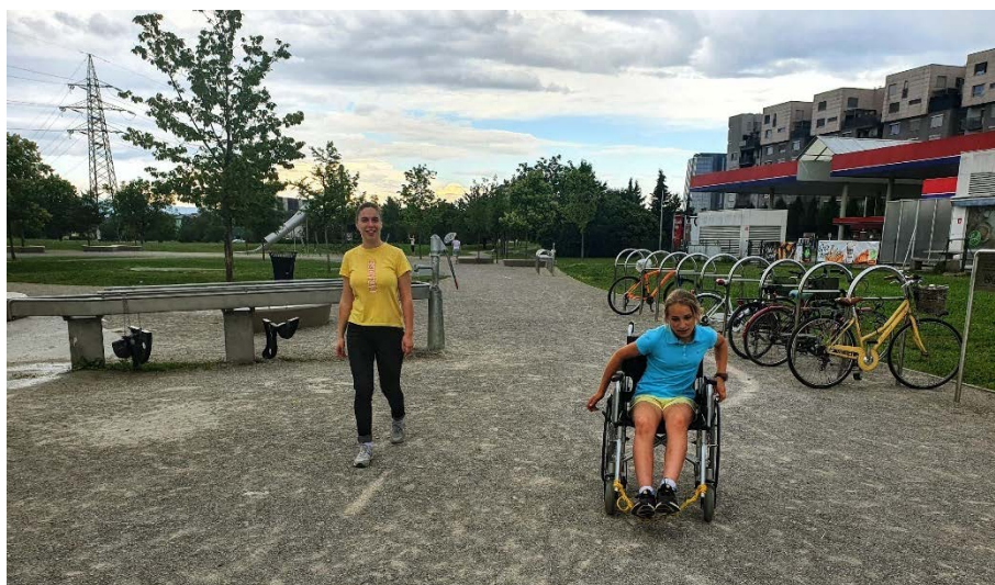
Slika: Pravilno izvedena dobro utrjena peščena podlaga, ki omogoča vožnjo z invalidskim vozičkom (foto arhiv projekta).
