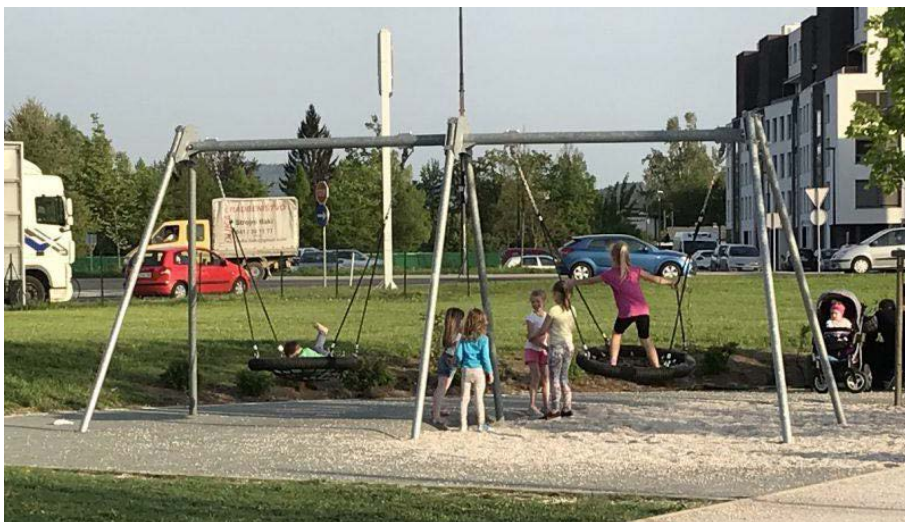
Slika: Gugalnica gnezdo z EPDM varnostno podlago, ki omogoča dostop z invalidskim vozičkom (levo) in druga, ki ima varnostno podlago izvedeno s cenejšim materialom – prodcem (desno), omogočata sočasno igro vseh otrok (foto arhiv projekta).
